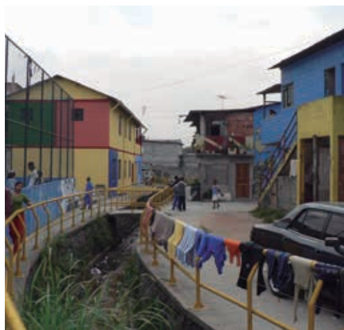
Infraestructura de drenaje en Jardim Iporanga, Sao Paulo, Brasil © Instituto de la Vivienda Asequible
