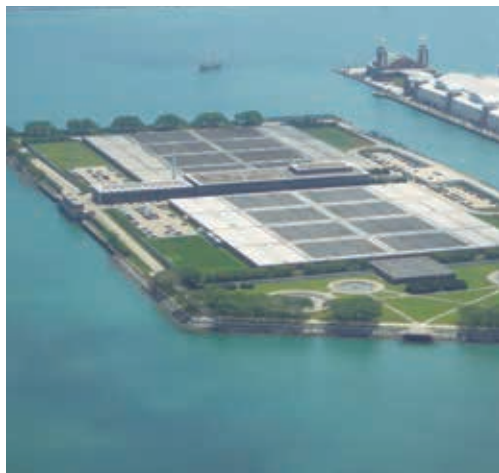
Planta de tratamiento de agua en Chicago, EE.UU. © Flickr/Neal Jennings/Sweet uno
