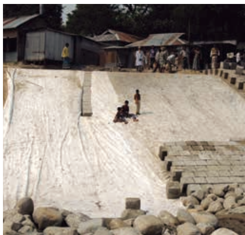
Orilla reforzada a lo largo del río Brahmaputra en Dhaka, Bangladesh © Leila Mead/IISD
