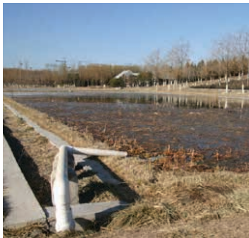
Humedal construido en el Parque Forestal Olímpico, Beijing, China © Flickr/Saneamiento sostenible
