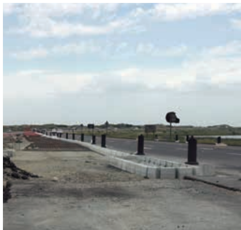
Vía en construcción, Ciudad del Cabo, Sudáfrica © Flickr/Warrenski
